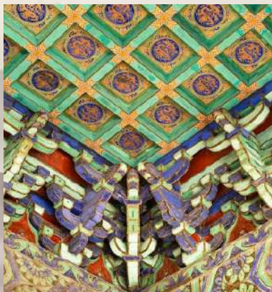
故宫内建筑物采用的榫卯结构
