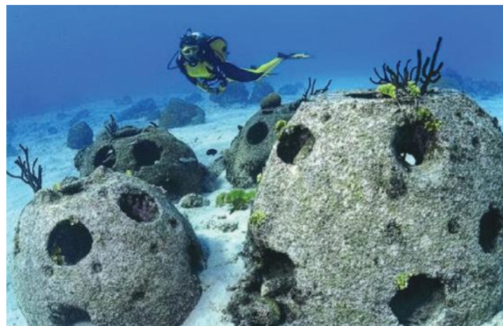
Fig. 1: Las bolas de arrecife de concreto prefabricado de la Reef Ball Foundation vienen en diversas formas y tamaños, pero la mayoría tienen forma de domo, con orificios o ranuras que permiten el paso del agua y de la vida marina a través de ellas (fotografía cortesía de la Reef Ball Foundation).
