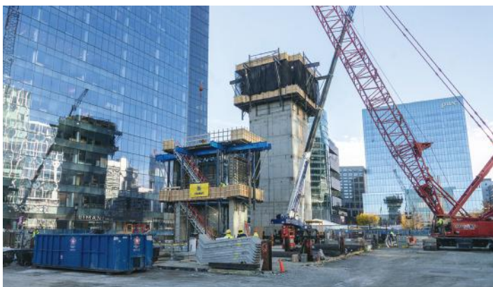
Núcleos con alturas de cimbra de hasta 20 pies (6 m) pueden colarse al mismo tiempo o antes del colado de losas
