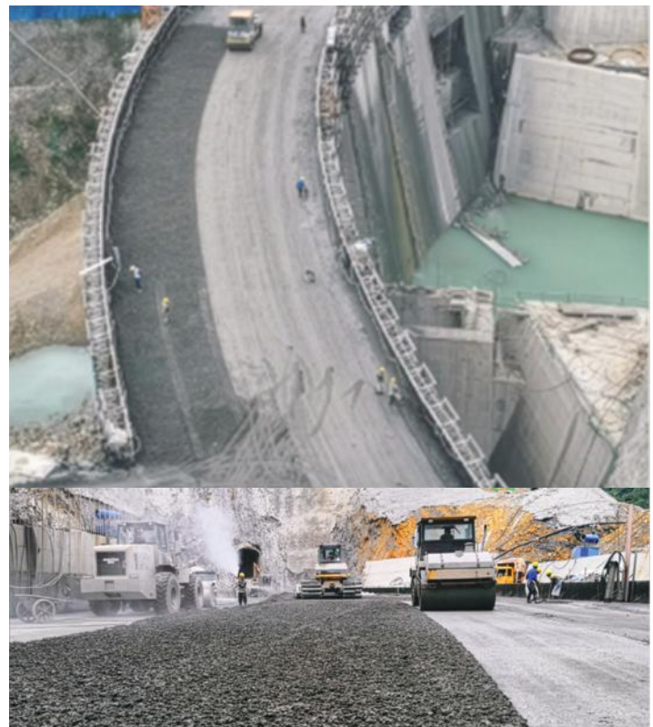
Figura 3: Presa de arco de concreto CCR de Longtan en Guangan, durante su construcción (según Li et al. 15 y Chen 16 )
