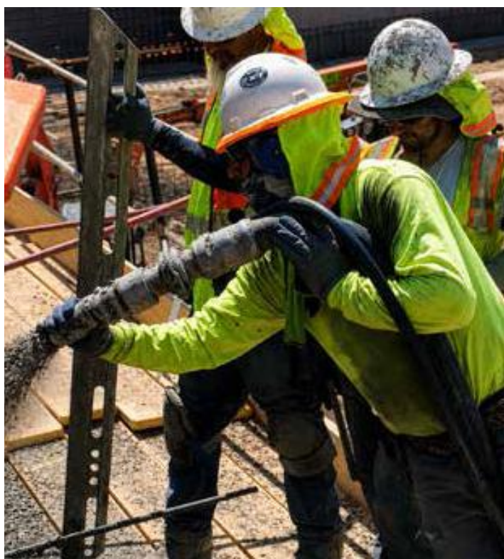
Fig. 3: Lanzador utilizando una postura adecuada para la colocación de concreto lanzado.
