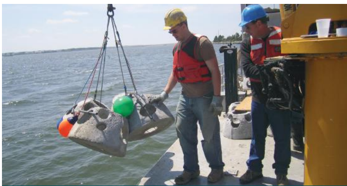
Fig. 5: Voluntarios de la Chesapeake Bay Foundation (CBF) colocando bolas de arrecife en el río Lafayette, en Norfolk, Virginia, EE. UU. (fotografía cortesía de la Chesapeake Bay Foundation).
