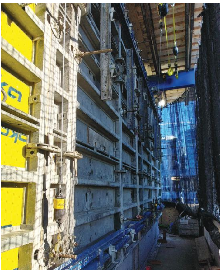
Las plataformas en el sistema Super Climber modificado para muros de cortante tienen un ancho de 6 pies (1.8 m)
