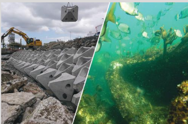
Uso de la tecnología de concreto bioenriquecido de ECONcrete en revestimientos costeros del Puerto de Bilbao (izquierda) y en un revestimiento para el proyecto Living Ports del Puerto de Vigo (derecha), ambos en España (fotografías cortesía de María Moltesen).
