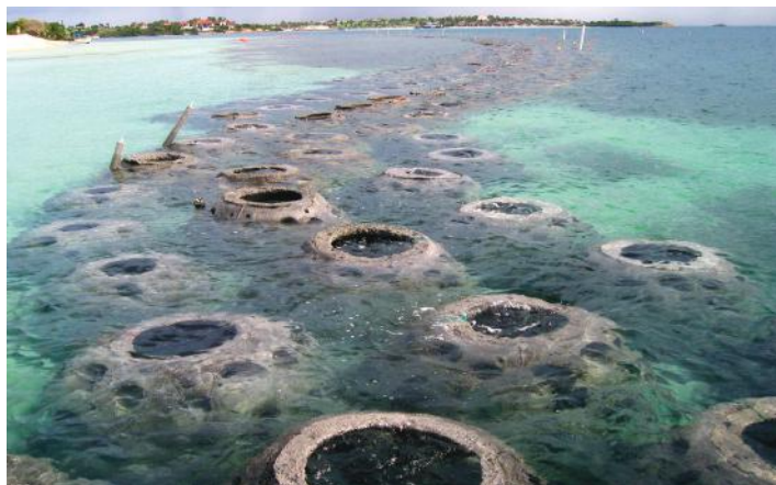
Fig. 6: Las bolas prefabricadas son especialmente útiles en la restauración de arrecifes de coral, ya que imitan los bloques de piedra caliza a los que se adhieren los organismos marinos (fotografía cortesía de la Reef Ball Foundation).
