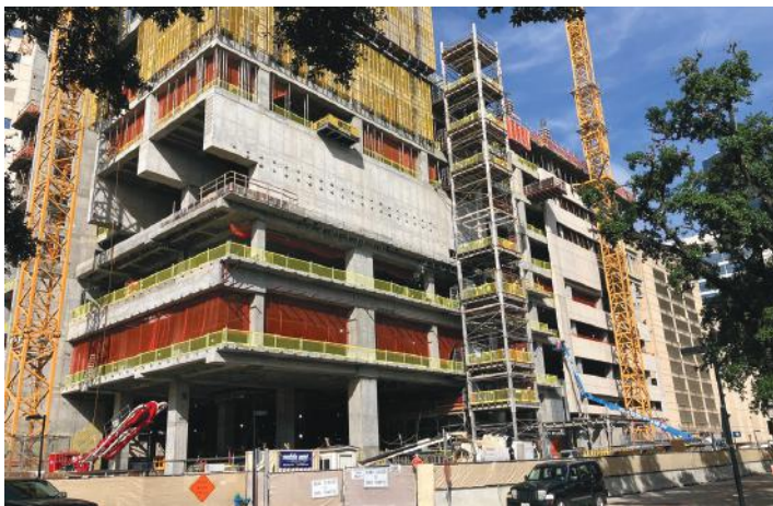
El proyecto de la Torre del Centenario del Sistema Hospitales Metodista en el Centro Médico de Texas en Houston, requirió de una viga de transferencia de concreto en voladizo de esquina de 14 m.
