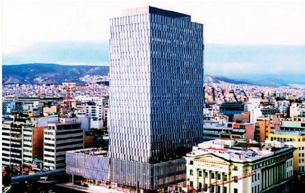
ΕΡΓΑ ΜΕΤΑΛΟΥΜΙΝ: Αττική, «Πύργος Πειραιά» κτίριο 22 ορόφων, φωτοβολταϊκή εγκατάσταση οροφής
