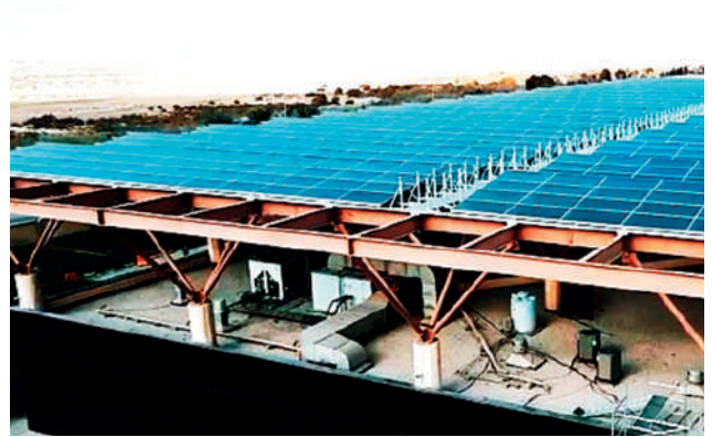
ΕΡΓΑ ΜΕΤΑΛΟΥΜΙΝ: Ριάντ, Σ. Αραβία, ειδική κατασκευή οροφής
