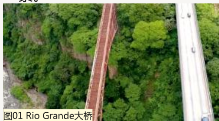
图01 Rio Grande大桥
