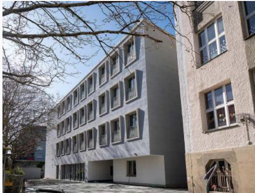
Neubau Ludwig Uhland Grundschule Bildquelle: WBG KOMMUNAL
