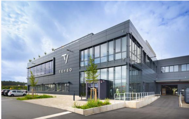
Für das Sportbekleidungs-Start-up Teveo hat Goldbeck eine Logistikhalle im Gewerbepark Ansbach-West bei Nürnberg errichtet. Der Neubau ist mit einem DGNB-Zertifikat in Platin ausgezeichnet. Bildquelle: GOLDBECK GmbH
