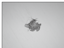
Abolladura en el vidrio
