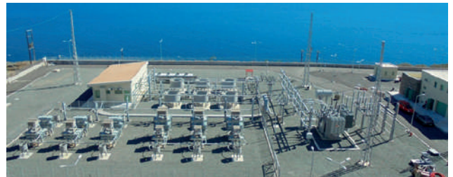
Static Var Compensation Υ/Σ Σύρου
