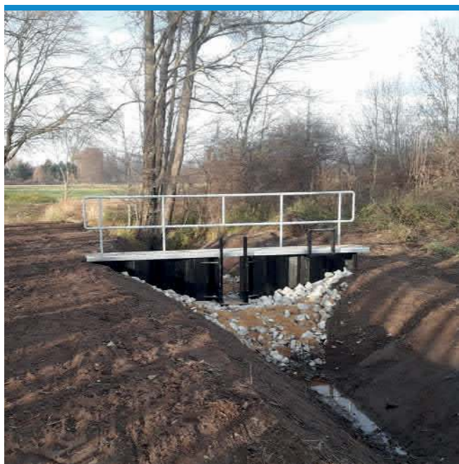
neu errichtetes Staubauwerk mit Stützschwelle an der Einmündung zum Priorgraben
