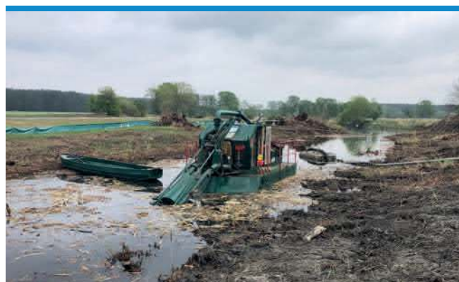
Entschlammung Altarm 2 mit Saugspülbagger
