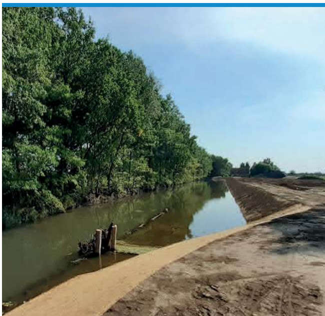
Zustand nach Profilaufweitung mit Berme für spätere Weichholzaunpflanzung
