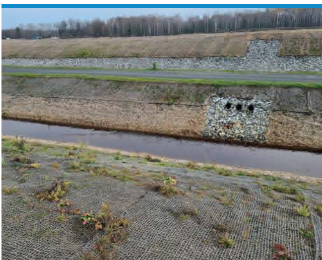
Gefluder Dränageeinleitung
