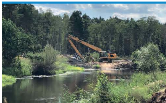
Entschlammung Altarm 1 mit Langarmbagger
