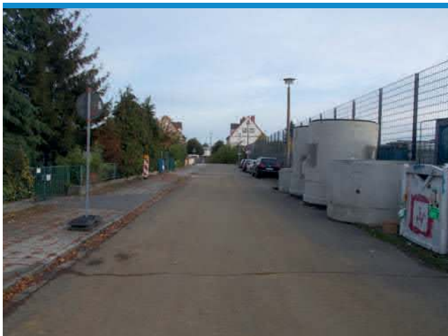
gelagerte Absenkschachtelemente
