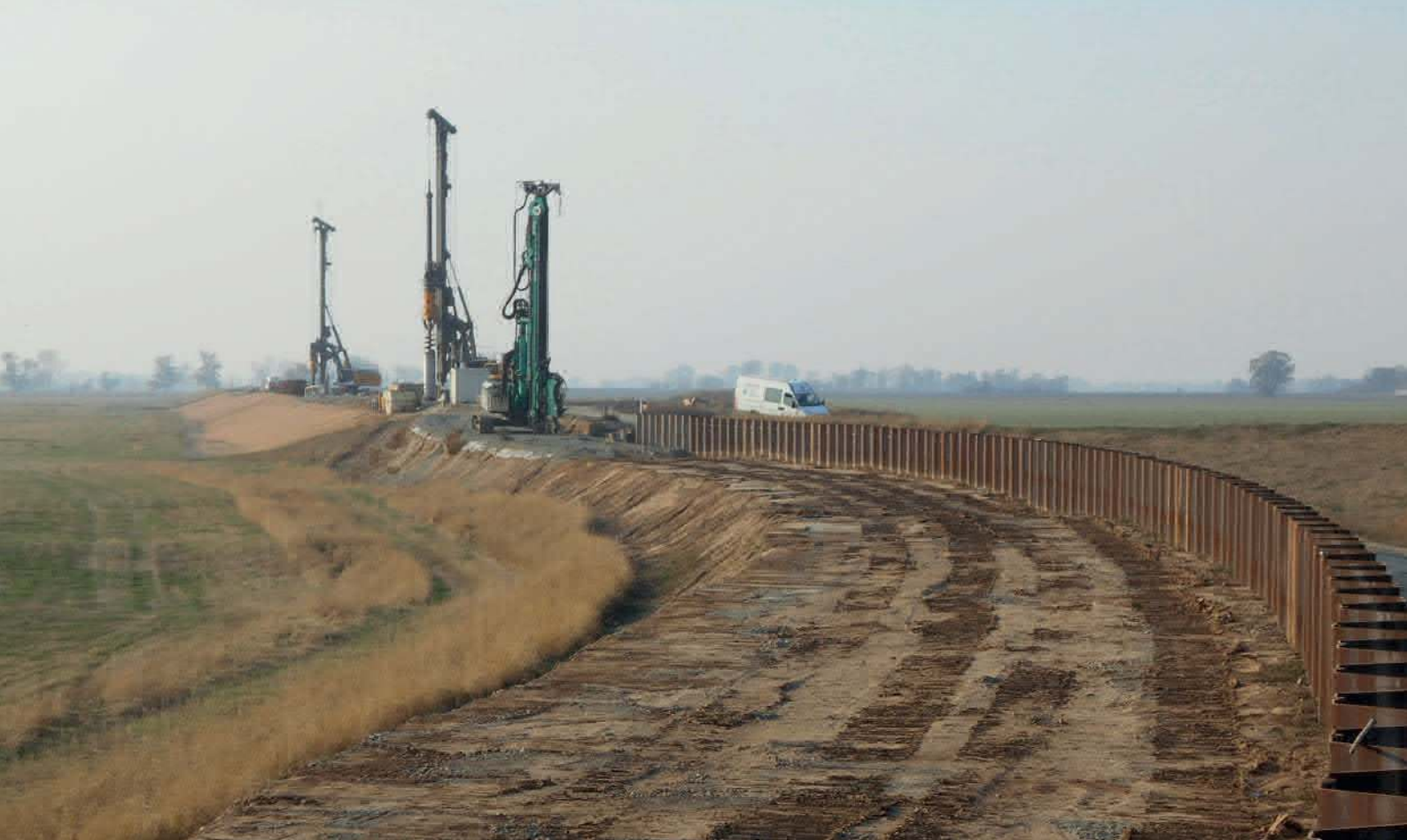
im Bau befindlicher Deichabschnitt mit Baumaschinen für Spundwand- und Bohrpfahleinbau
