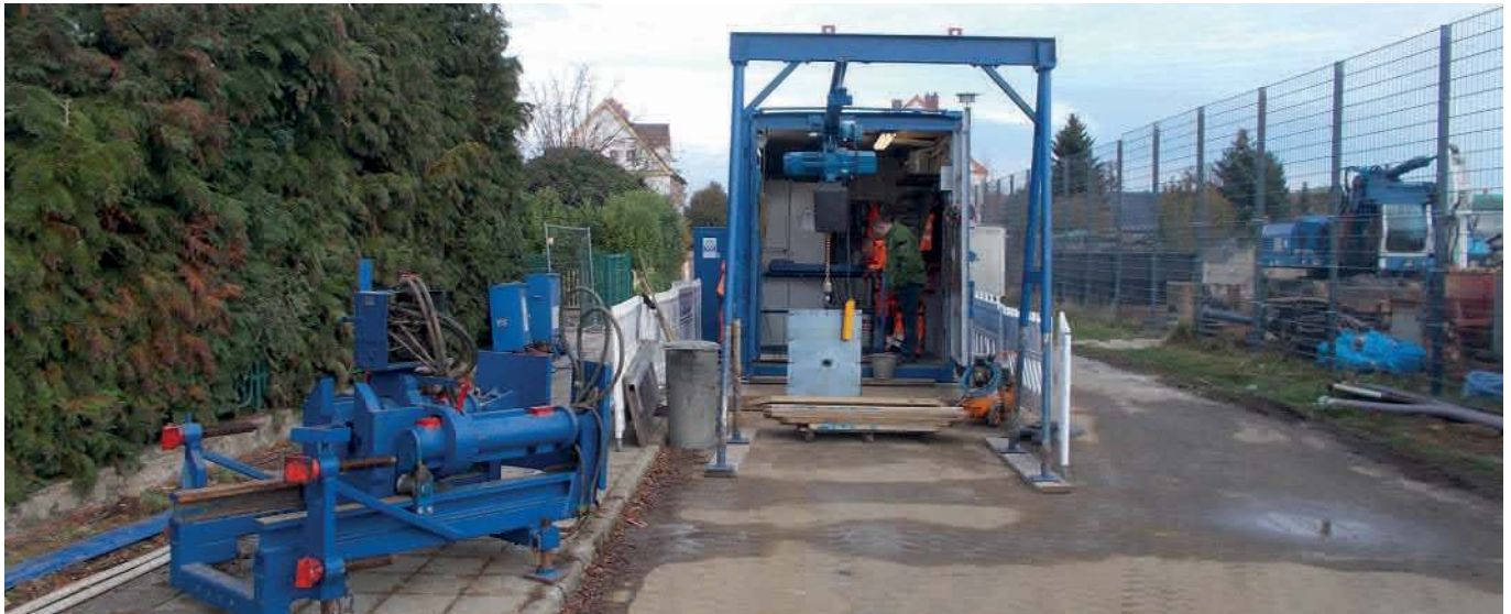
Vortriebsanlage vor dem APW F.-Engels- Straße
