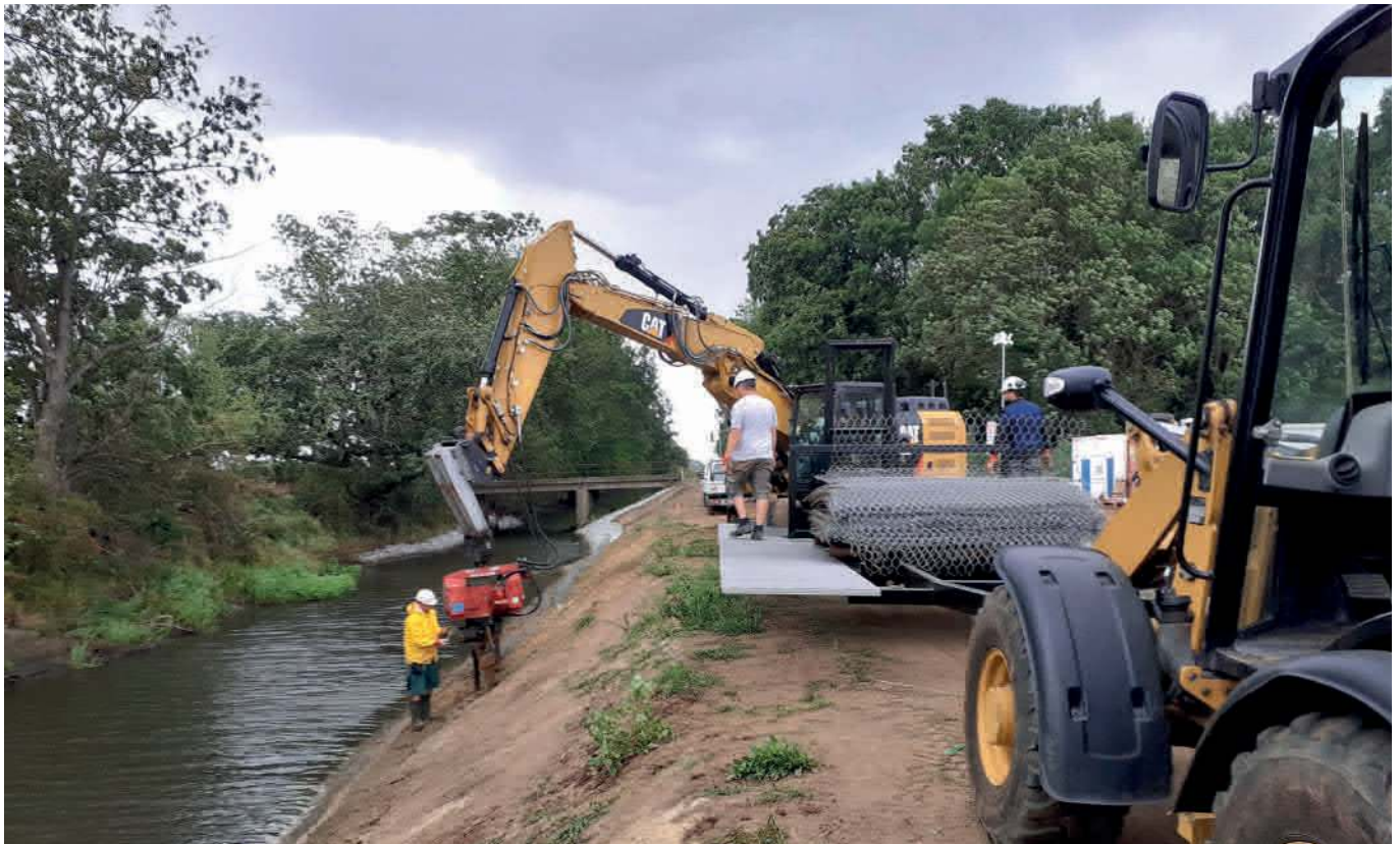
Einbringen des Biberschutzgitters
