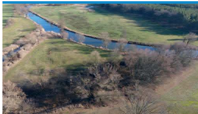
Altarm 2 vor Baubeginn
