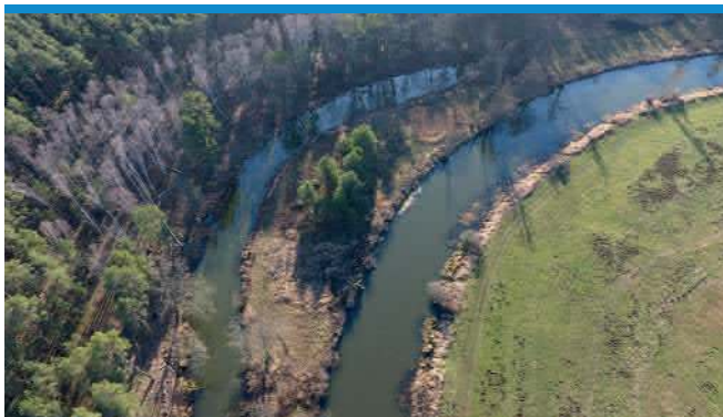
Altarm 1 vor Baubeginn
