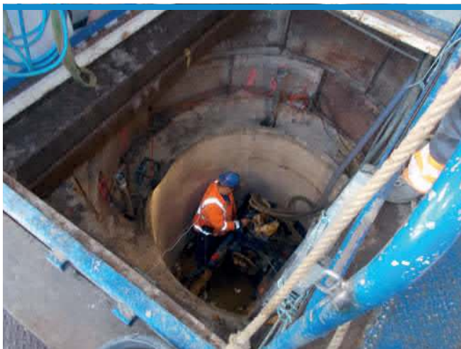
Einrichten der VT- Anlage
