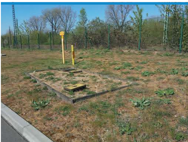
Erweiterung der Gasversorgung
