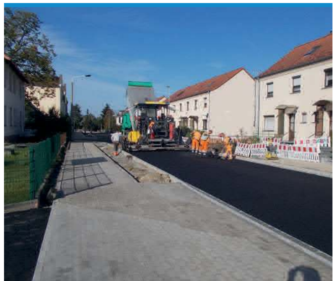
Asphalteinbau im 2. Bauabschnitt 2. Teilabschnitt
