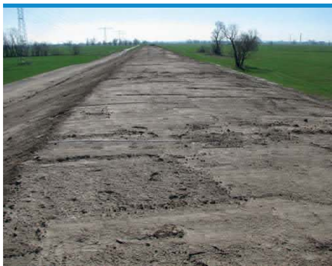
fertig profilierter Deichabschnitt vor Begrünung
