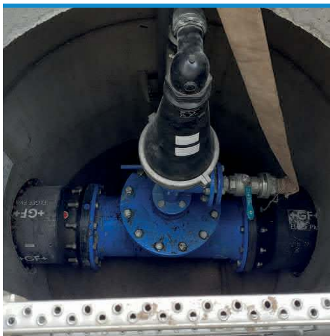
am Düker verbautes Be- und Entlüftungsventil mit Flutsperre für Trinkwasser
