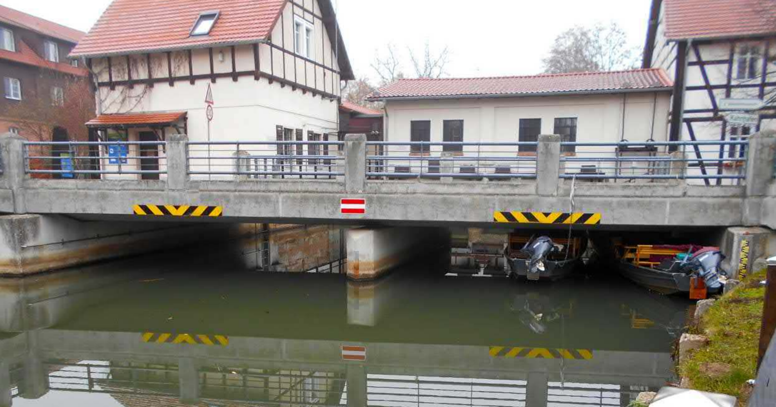
Wehranlage aus dem Oberwasser
