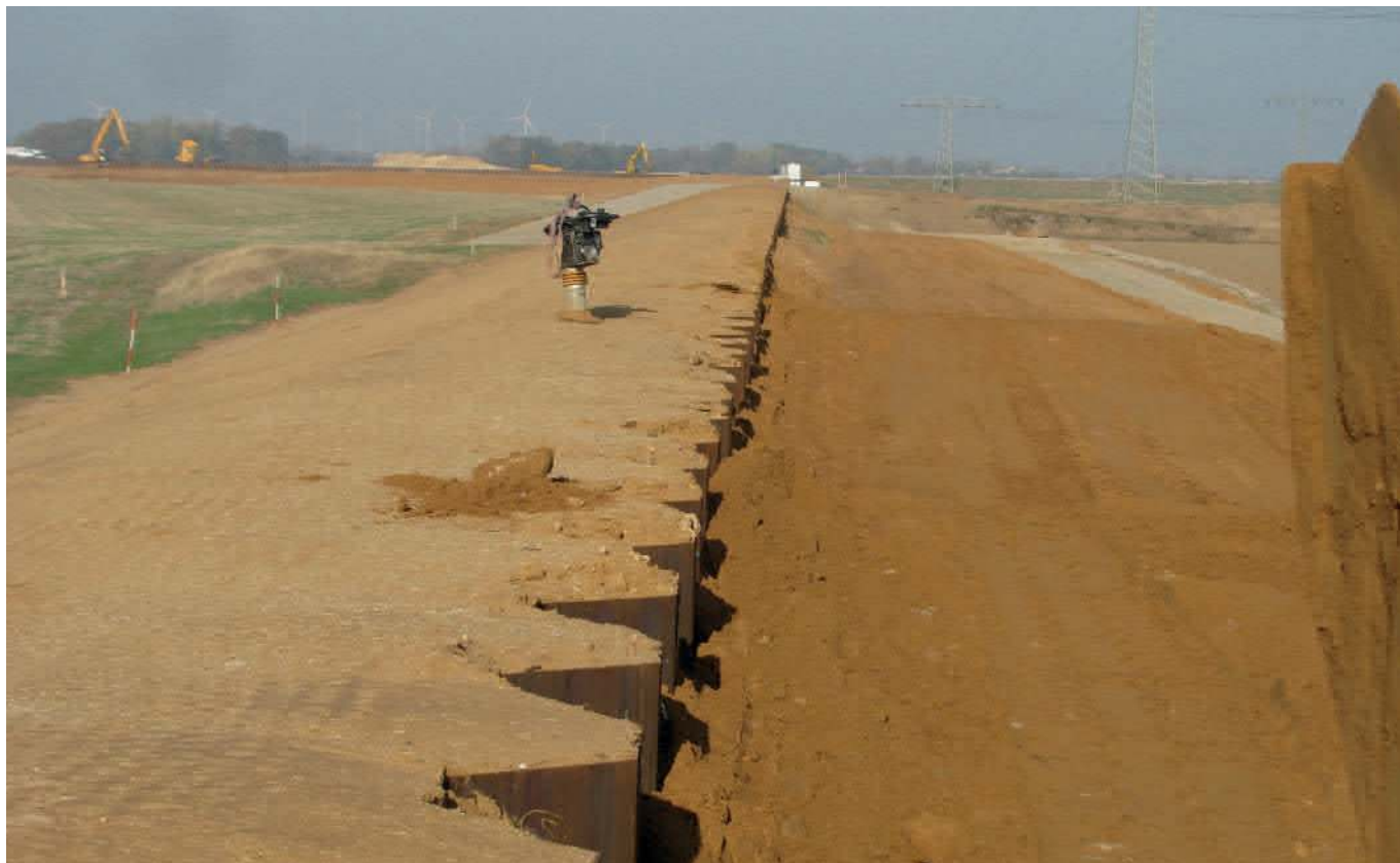
fertiggestellte Spundwand in der Deichachse
