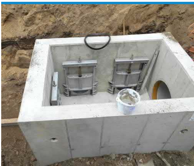
RW-Abschlagsbauwerk zum Jahnteich
