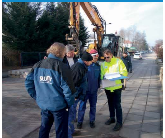
fachlicher Disput am Abschlagsbauwerk RW im 1. Bauabschnitt
