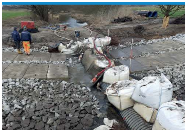
Gewässerüberleitung aus PE-HD Verbundrohr (DN 800) zur Herstellung der Furt im Priorgraben
