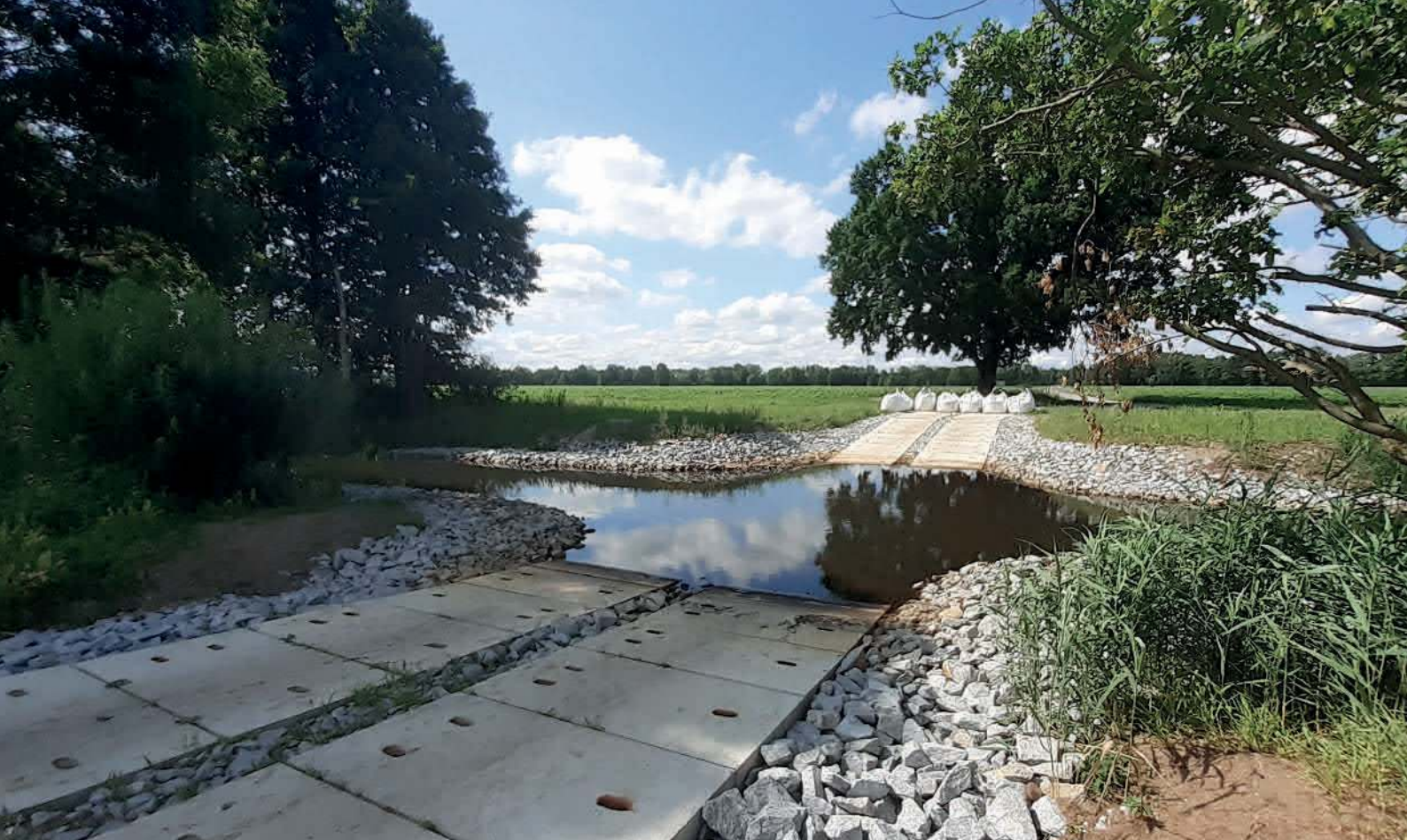
Furt Priorgraben nach Fertigstellung
