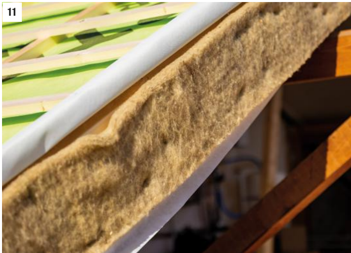
11 Biobased daksysteem voor corporatiewoningen in Kaatsheuvel, waar Hazenberg op grote schaal biobased isoleert: minder CO 2 -uitstoot, meer comfort én sneller gerealiseerd dankzij een prefab daksysteem, mede mogelijk gemaakt door de TBI Klimaatrein. 12 Een van de schottenketen van MDB, gebruikt bij het project De Groene Boog (A16 Rotterdam), kreeg een tweede bestemming in Centraal-Oekraïne: als noodhuisvesting voor mensen die geëvacueerd moesten worden uit het frontgebied.
