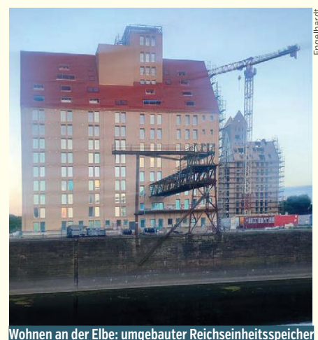
Wohnen an der Elbe: umgebafter Reichseinheitsspeicher
