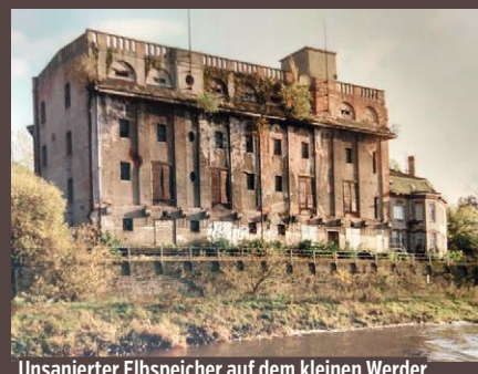
Unsanierter Elbspeicher auf dem kleinen Werder
