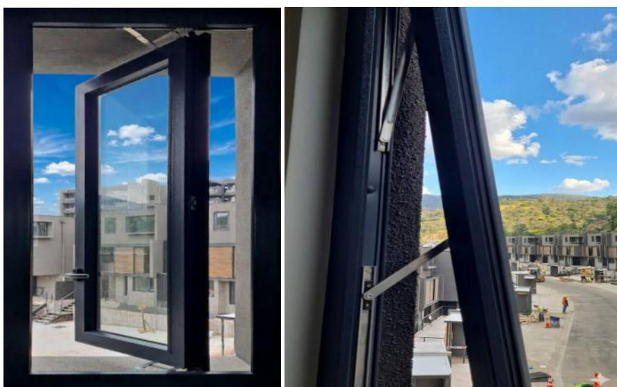
Los herrajes incorporan manilla negra, cierre oculto para apertura total y brazos reforzados que facilitan la limpieza del vidrio exterior.
