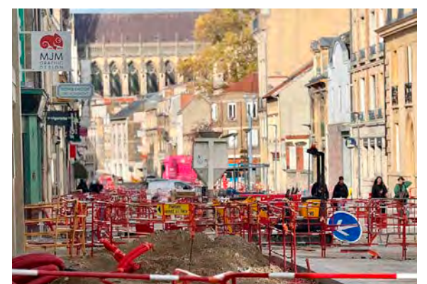
Le chantier de la voie des Sacres a démarré à l'été 2024. © Archives l'Hebdo du Vendredi
