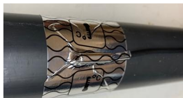
Figura 4 – Instalação da Sonda de Temperatura
