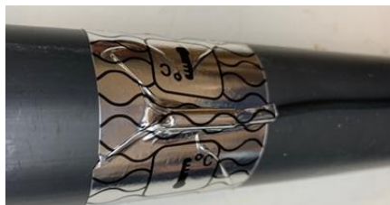
Figure 4 – Installation de la sonde de température
