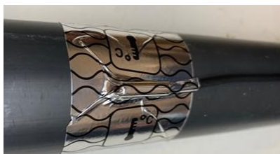
Fig 4 – Installazione della sonda di temperatura
