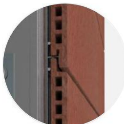
CANTERÍAS / JUNTA DE DILATACIÓN
