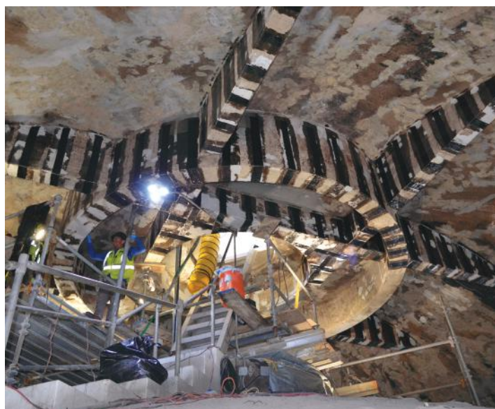
Reforzamiento utilizando láminas de fibra de carbono.
