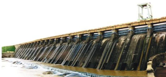
Fig. 2: Presa Hirakud, Sambalpur, Odisha, India (foto cortesía de P.K. Mallick)
