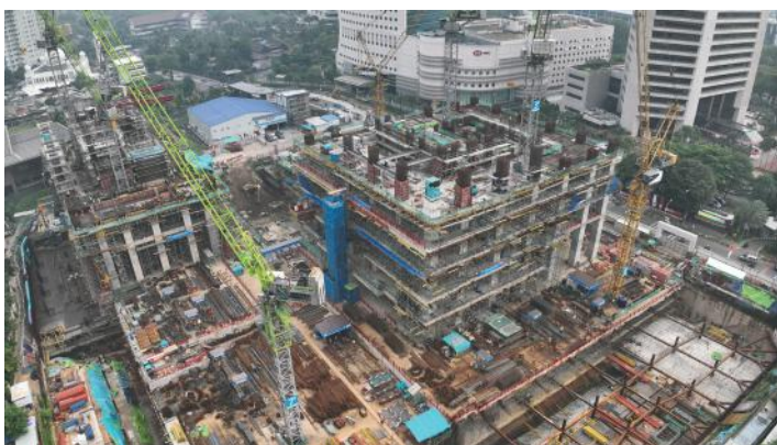
Fig 7: Boceto conceptual del complejo The Two Sudirman (izquierda), que muestra la torre de uso mixto planificada de 331 m (1 086 pies) y la torre residencial de 276 m (906 pies), junto con el progreso de construcción del 8% hasta septiembre de 2025 (derecha) (imagen y foto cortesía de Mitsubishi Estate Indonesia)
