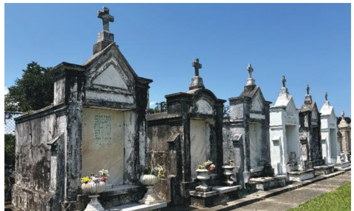
Fig. 5: Vista del Cementerio de San Luis Núm 3 en Nueva Orleans, LA, EE.UU. (Foto cortesía de K.E. Sheridan)
