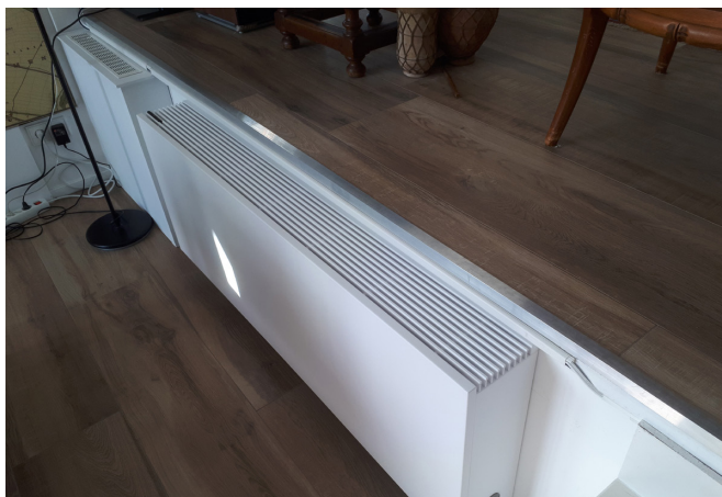
Lage temperatuurradiator in de 'waterkamer' voor extra warmteafgifte
