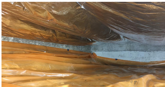
De geïsoleerde kruipruimte
