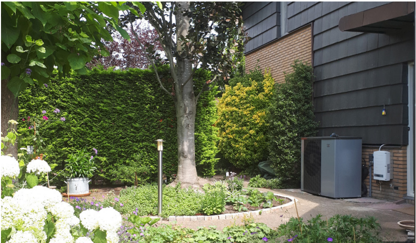
Buitenunit van de warmtepomp, daarnaast de omvormer van de zonnepanelen
