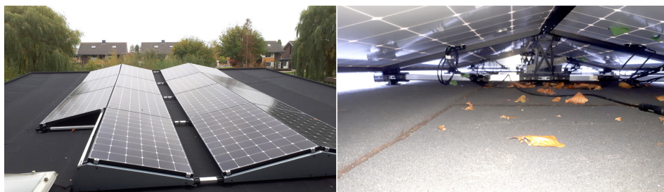
15 oost-west georiënteerde zonnepanelen op het 'grote dak' en een 'lege fabriekshal' onder twee panelen
