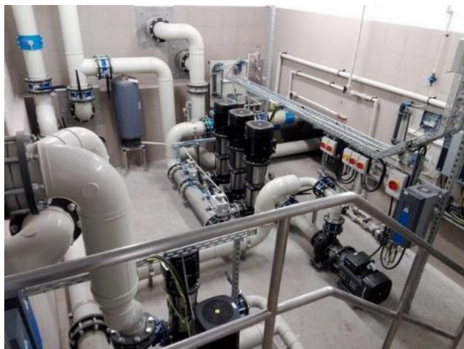
A vízműtelep szivattyútere.
