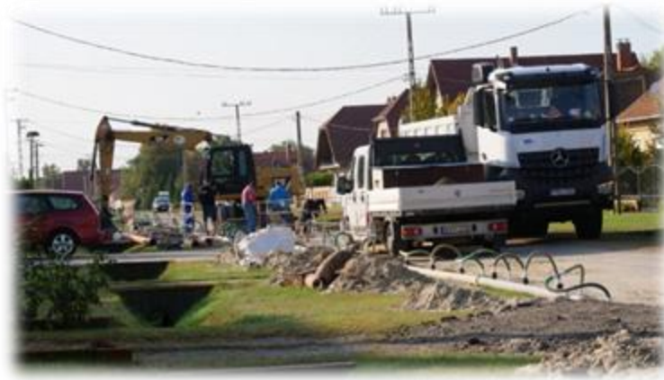
Szennyvízsatorna rekonstrukciós munkálatok a Bartók Béla utcában (2019).
