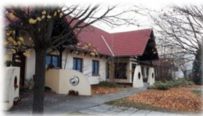
A kialakítás alatt lévő Szilágyi Kollégium épülete.
