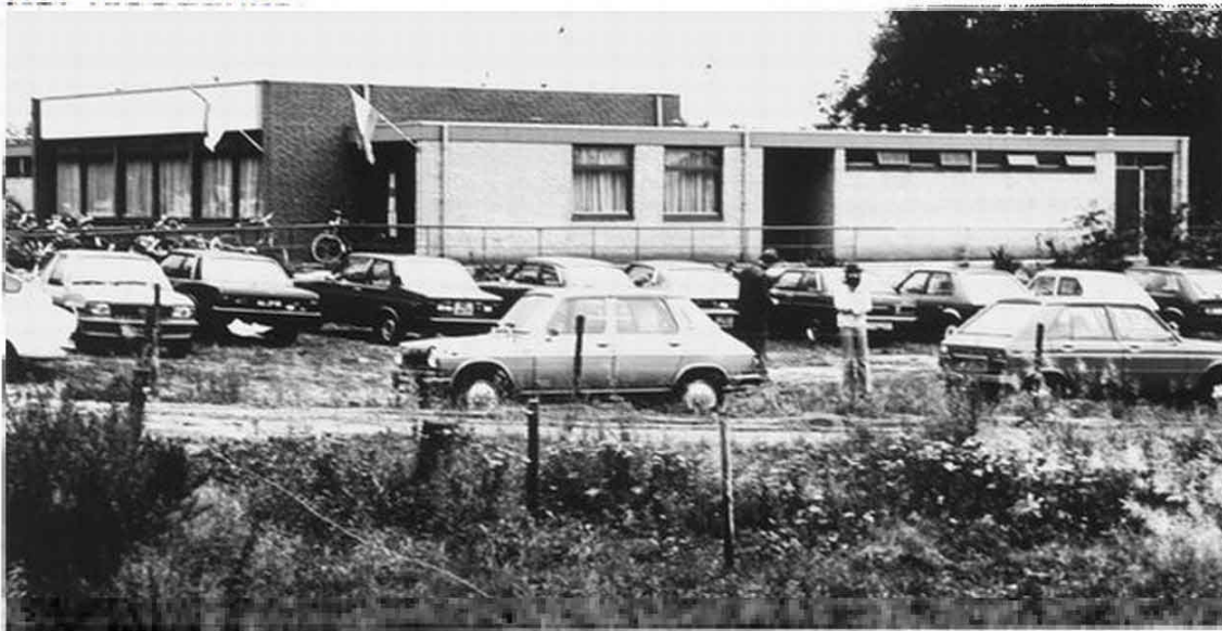
Parkeerproblemen bij ZSV. In 1982 werd een nieuwe parkeerplaats aangelegd door zelfwerkzaamheid van de leden.
