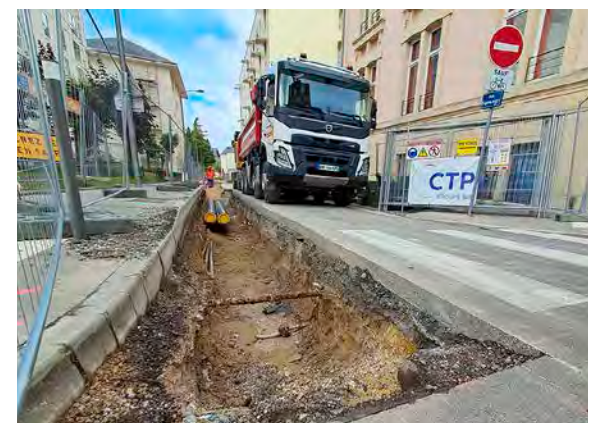
À Saint-Remi, les travaux d'extension du réseau de chaleur ont débuté récemment. © l'Hebdo du Vendredi
