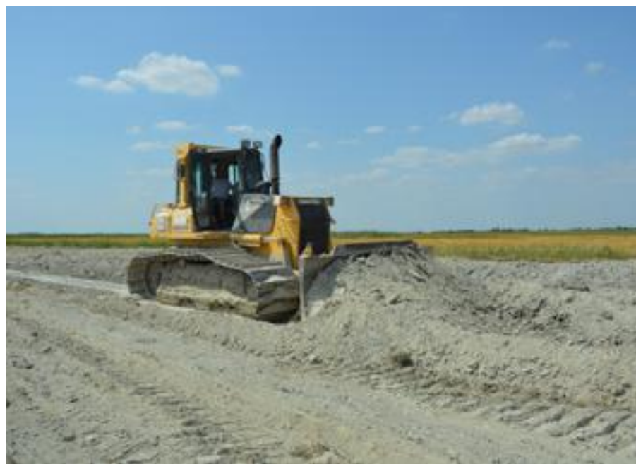
Nagy földtömegű mellécsatorna betemetése Fotó: Mile Orsolya
