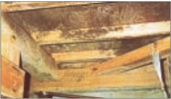
▲床下換気システムを設置していない床下
