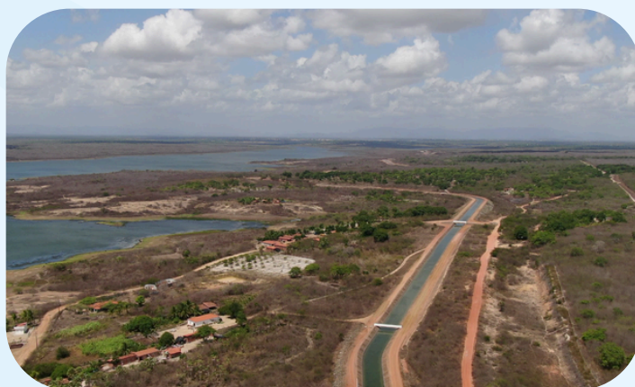
Foto 5 - Canal Eixão das Águas, trecho IV, Fortaleza - CE. Foto: GR Metropolitanas.
