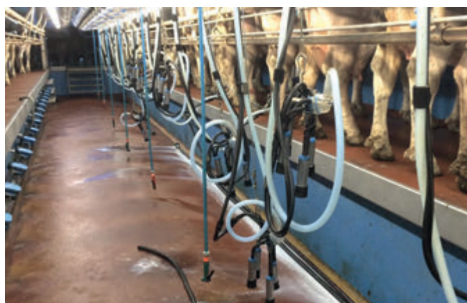
Salle de traite 20 postes - Simple équipement
