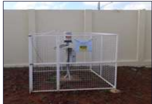
Figura 2 - Estação Telepluviométrica instalada no Município de Caetés-PE.
