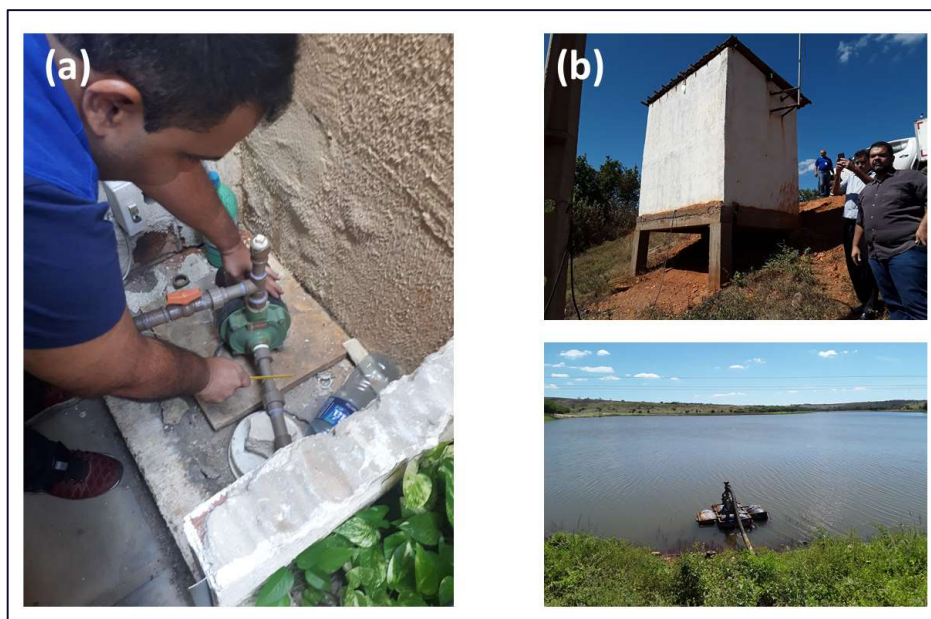
Figura 16 - Fiscalização em condomínio (a) e na Barragem Paulo Coelho (b).
