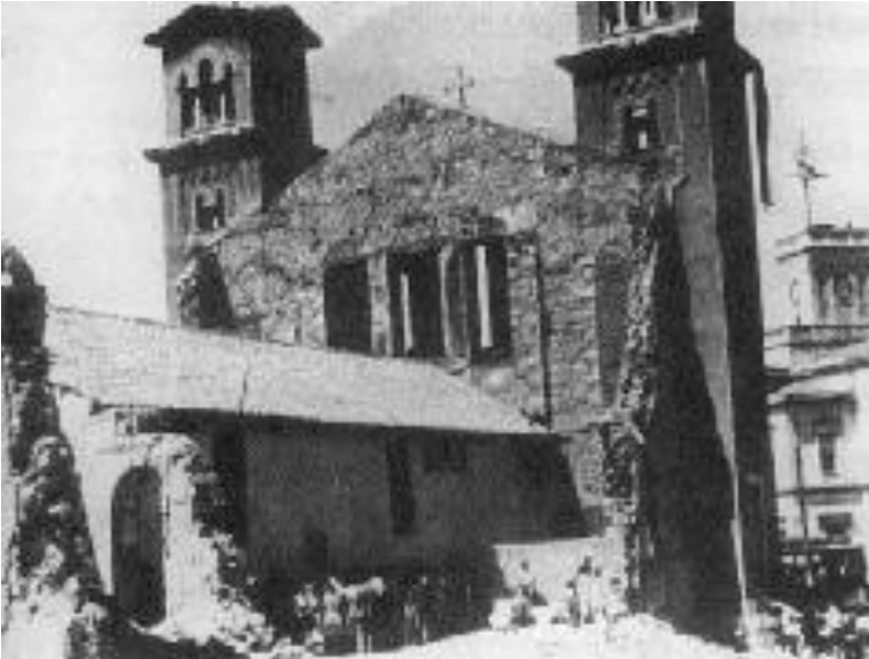
Μεταπολεμική φωτογραφία της Αγίας Τριάδας. Έχει διασωθεί μόνο η πρόσοψη του ναού ενώ στο υπόλοιπο κατεστραμμένο μέρος, έχει ανεγερθεί μια πρόχειρη κατασκευή.
