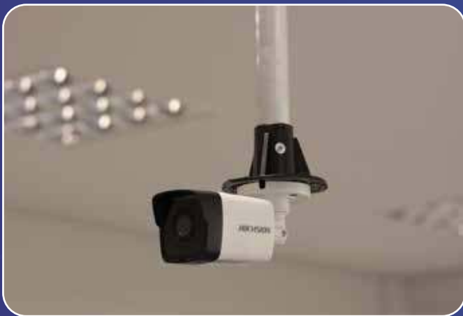
Instalação das novas câmeras
