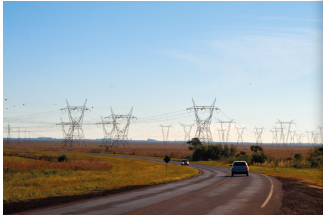
Tendido de alta tensión proveniente de la Entidad Binacional Yaciretá. SEBASTIÁN MALIZIA.
