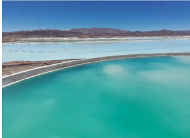
Tanque de sedimentación de magnesio y estanques de evaporación de Minera Exar, Jujuy. ALFREDO GRAU.
