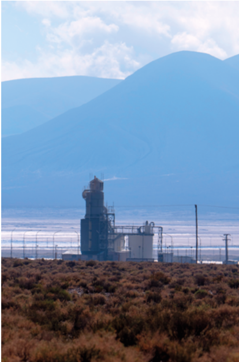
Planta de litio. GONZALO SALEME.
