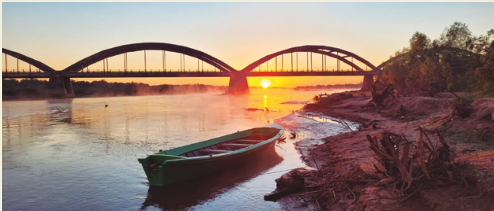
Puente sobre río San Francisco en provincia de Salta. PROYUNGAS.
