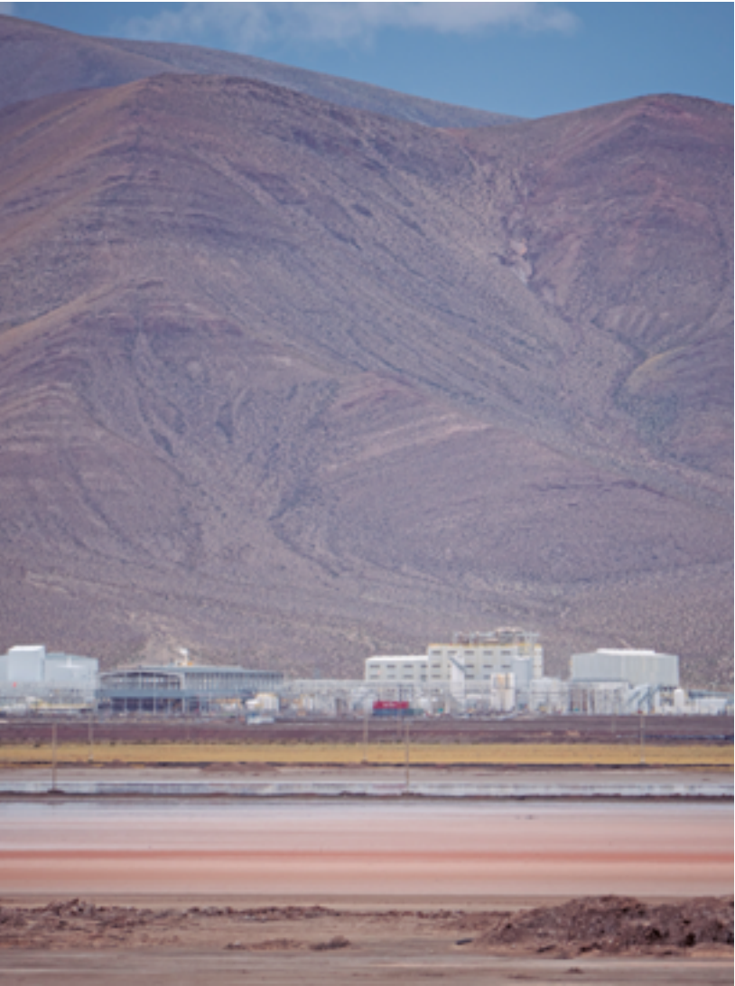
Planta de litio. GONZALO SALEME.
