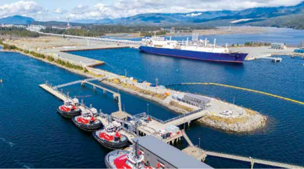
The LNG Canada marine terminal in Kitimat, B.C. in April 2026. Photo courtesy LNG Canada.
