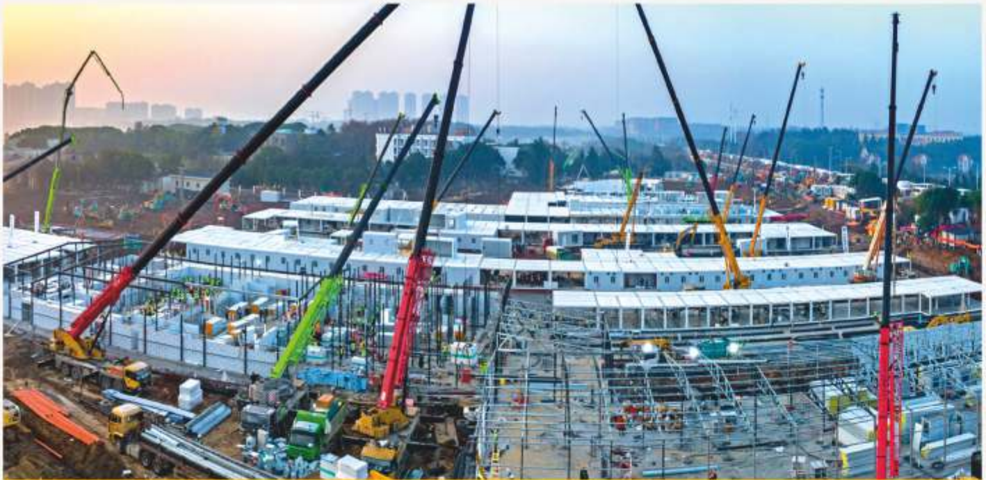
China State Construction Group, movilizó a más de 40.000 empleados para las tareas de construcción de los hospitales de Huoshenshan y Leishenshan en Wuhan
