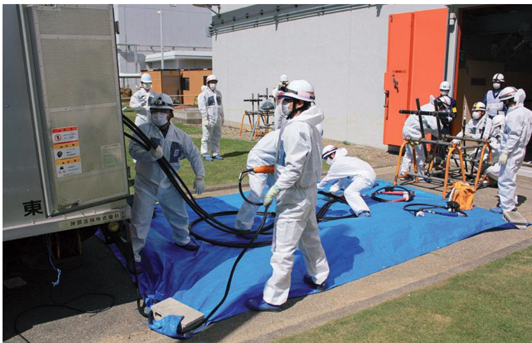
Langileak, Fukushima zentrala leheneratzeko lanetan. ARG.: TEPCO.
