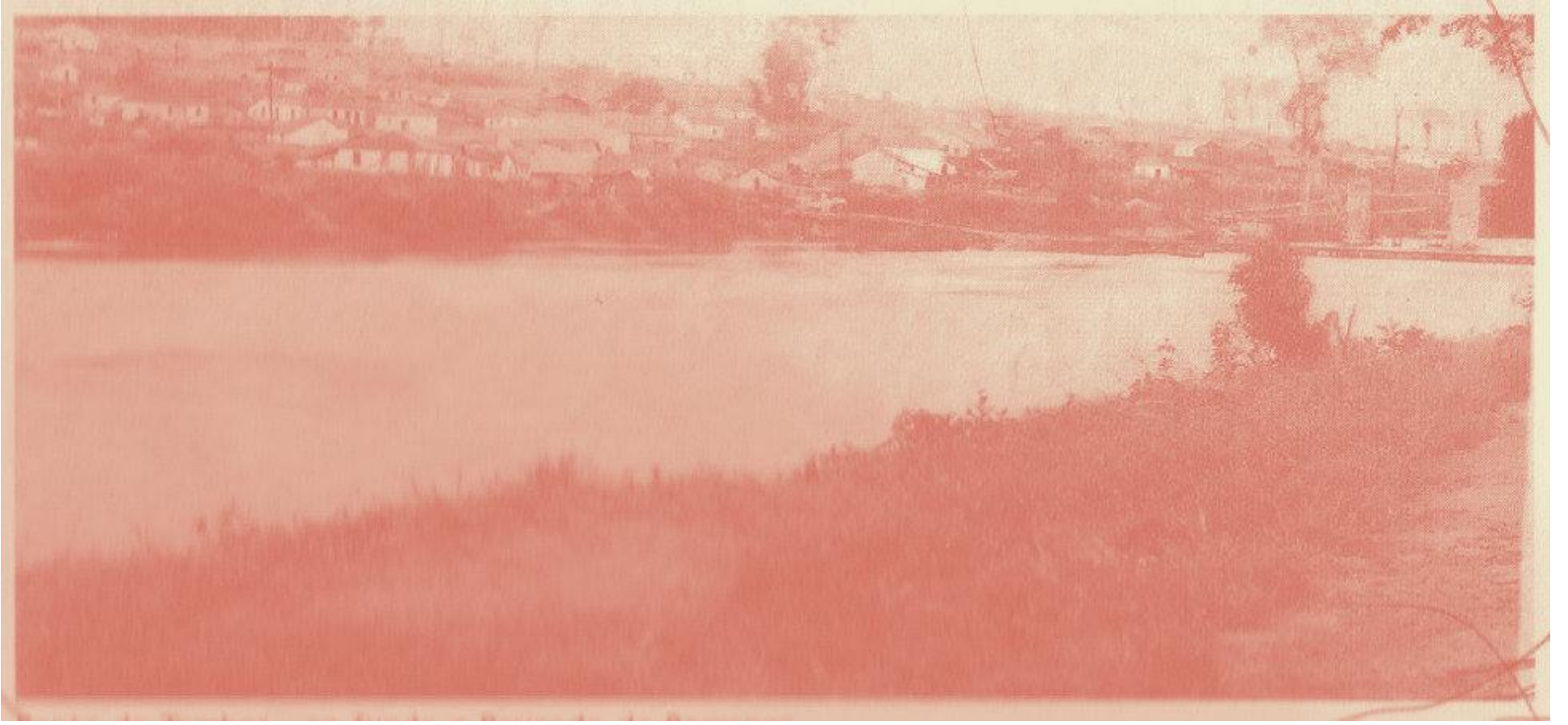
منظر لمدينة ريالما؛ وتظهر في الصورة الجسر الخشبي الذي شُيّد في أربعينيات القرن العشرين. حقوق الصورة: سيسيرو ليون جونيور
