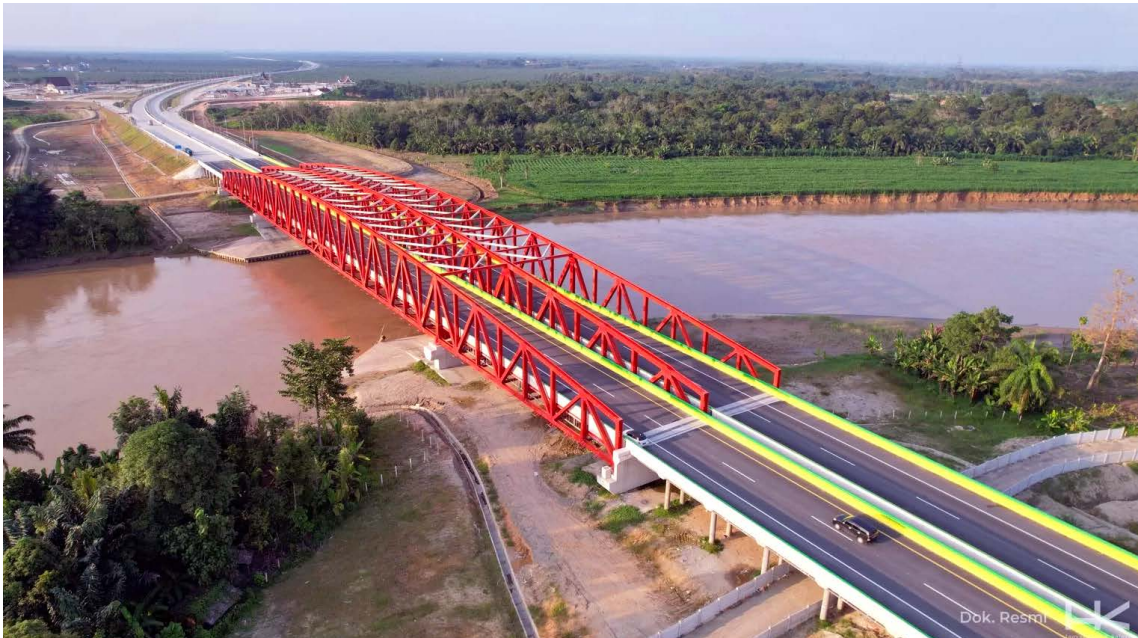
Jalan Tol Trans – Sumatera
