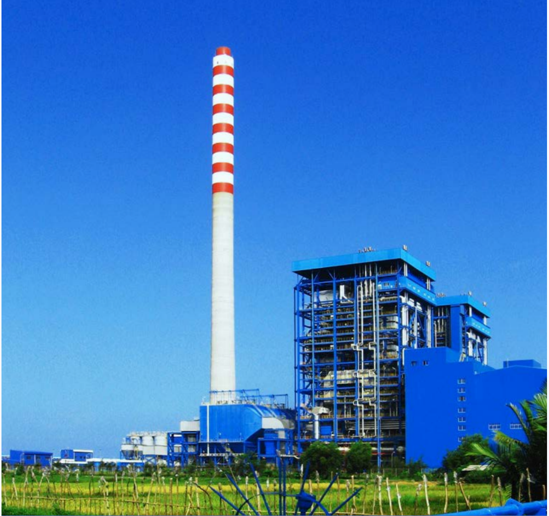
PLTU Karangandri dengan kapasitas yang dihasilkan mencapai 6.000 megawatt.
