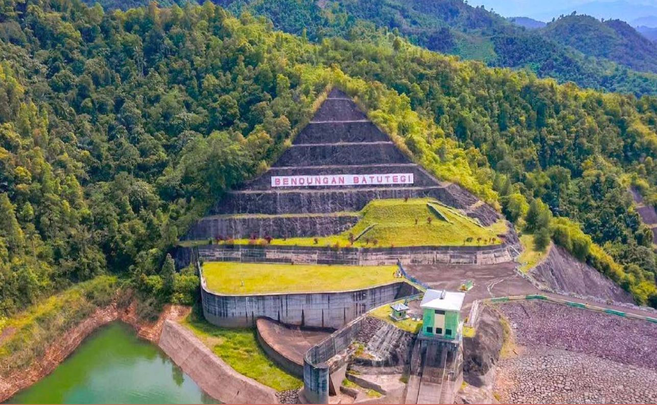
Bendungan Batutegi, Lampung
