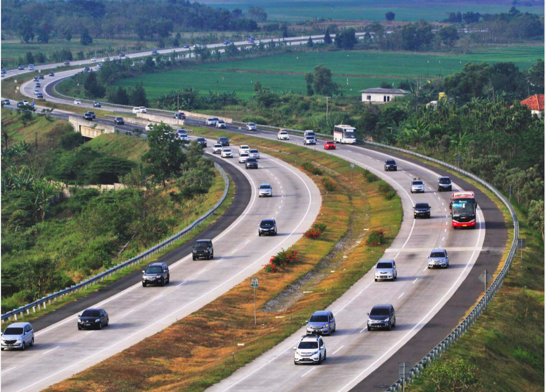
Jalan Tol Trans – Jawa
