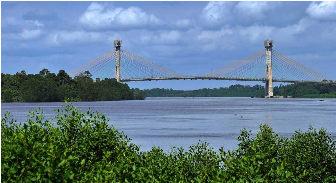
Jembatan Siak I Pekanbaru
