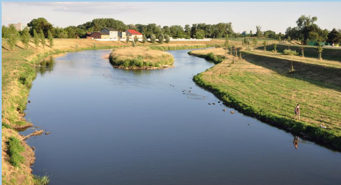
Zvýšení kapacity řeky Moravy bermou – berma využívaná k rekreaci (povodňový park) (foto Envicons)
