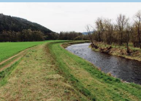
Protipovodňový val (foto Envicons)
