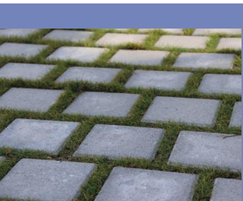
Zatrávněná vodopropustná dlažba (foto Unsplash)
