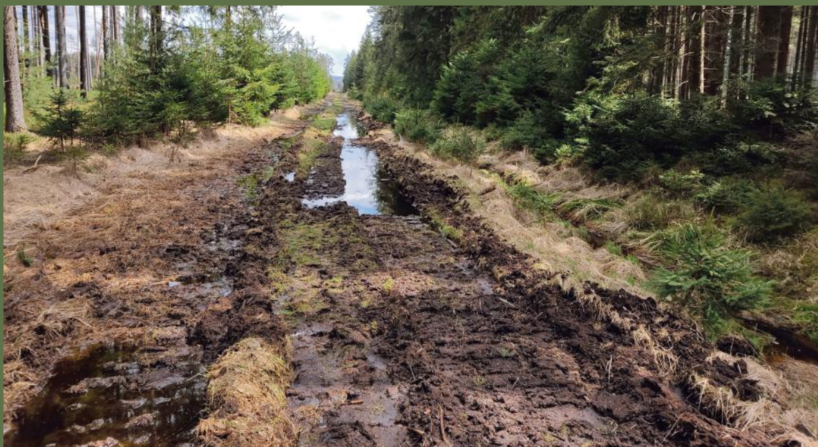
Cesta utužená lesní technikou nedokáže vsakovat vodu, absence odvodnění (foto Envicons)
