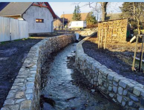
Protipovodňové opatření Rosice (projekt a foto: Envicons)
