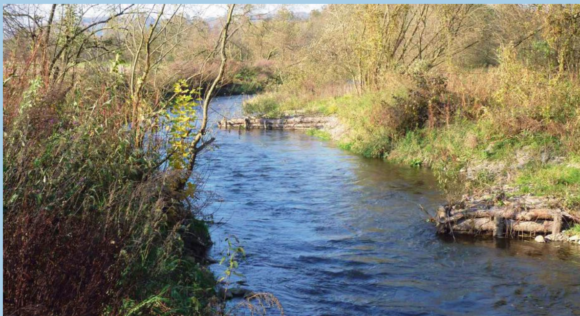
Výhony ze stromových kmenů a kamenů pro podporu renaturace (projekt a foto: Envicons)
