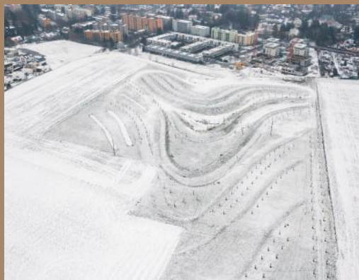
Park Z. Kopala Litomyšl – systém zasakovacích pásů, průlehu a příkopů ve svahu (projekt a foto: Eva Wagnerová, Envicons)
