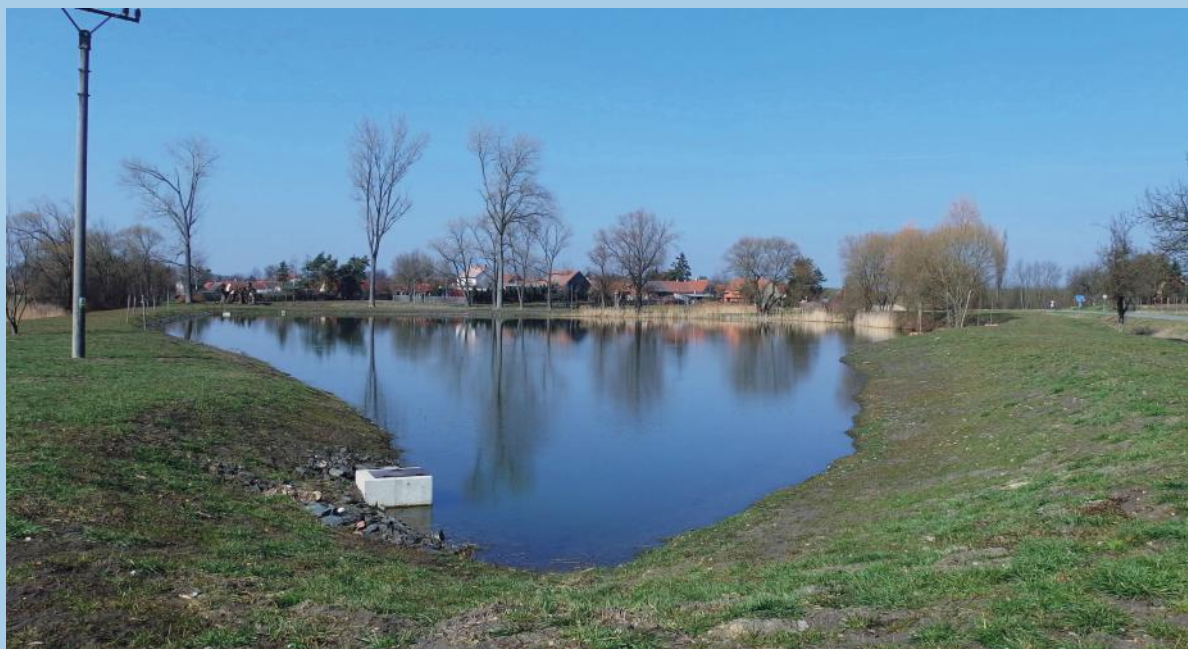
Malá vodní nádrž Chotěšice (projekt a foto: Envicons)
