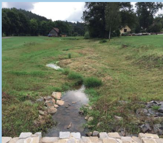
Odlehčovací koryto – protipovodňová opatření v Písečné (projekt a foto: Envicons)
