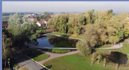
Zasakování dešťové vody ze střech okolních budov – obec Bratčice (Ing. Jan Varadínek, Ing. Dan Šamánek, foto D. Šamánek)
