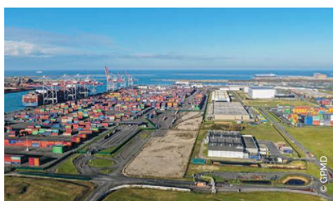
Le chantier Cap 2020 prévoit la création d'un nouveau quai de 1000 mètres afin d'accueillir un deuxième terminal conteneurs.
