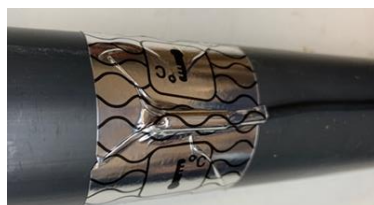
Figura 6 – Instalación de la Sonda de Temperatura
