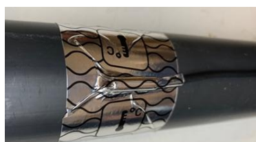
Figura 6 - Installazione della sonda di temperatura
