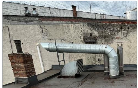
Výduchy z pražiarnie na streche · stav pred realizáciou
