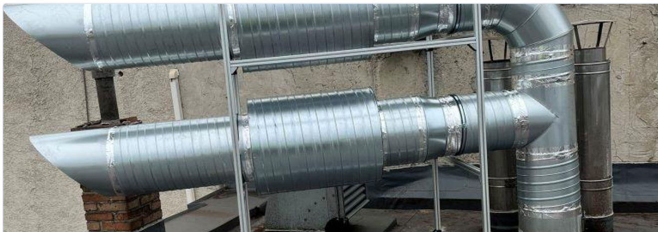
Tlmiace prvky osadené na výústeniach potrubí · stav po realizácii
