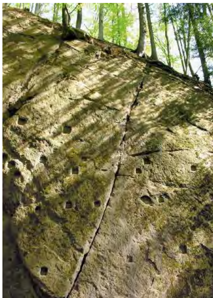
Gerüstlöcher an der Nordwand.
