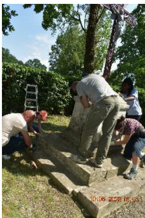
Rénovation des calvaires
