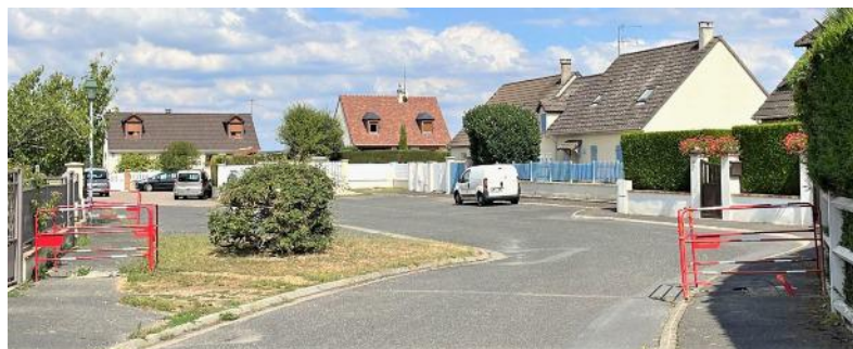
Éclairage public Allée de Marivaux
