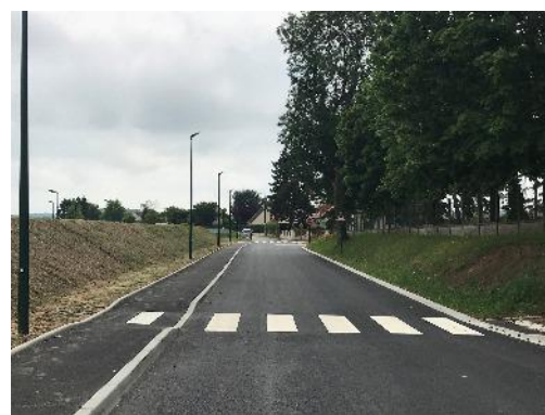
Travaux Rue de la Trinité
