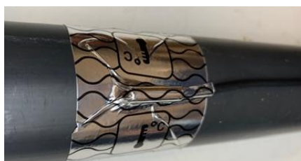
Figure 4 – Installation de la sonde de température
