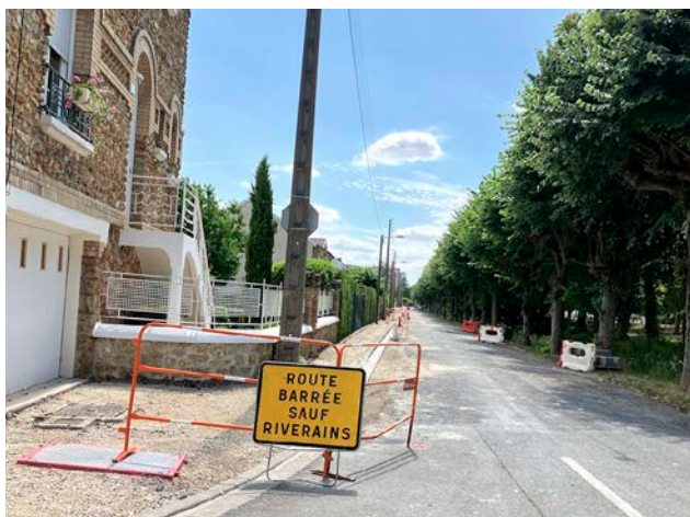
Le chantier de la rue de la Moivre, en direction du Verbeau, a déjà débuté. © L'Hebdo du Vendredi
