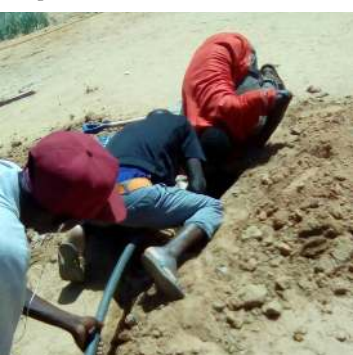
De waterpomp werd vervangen.
