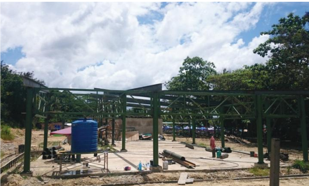
Kerja-kerja pembinaan PAKAR Keningau, Sabah Construction Works of PAKAR Keningau, Sabah
