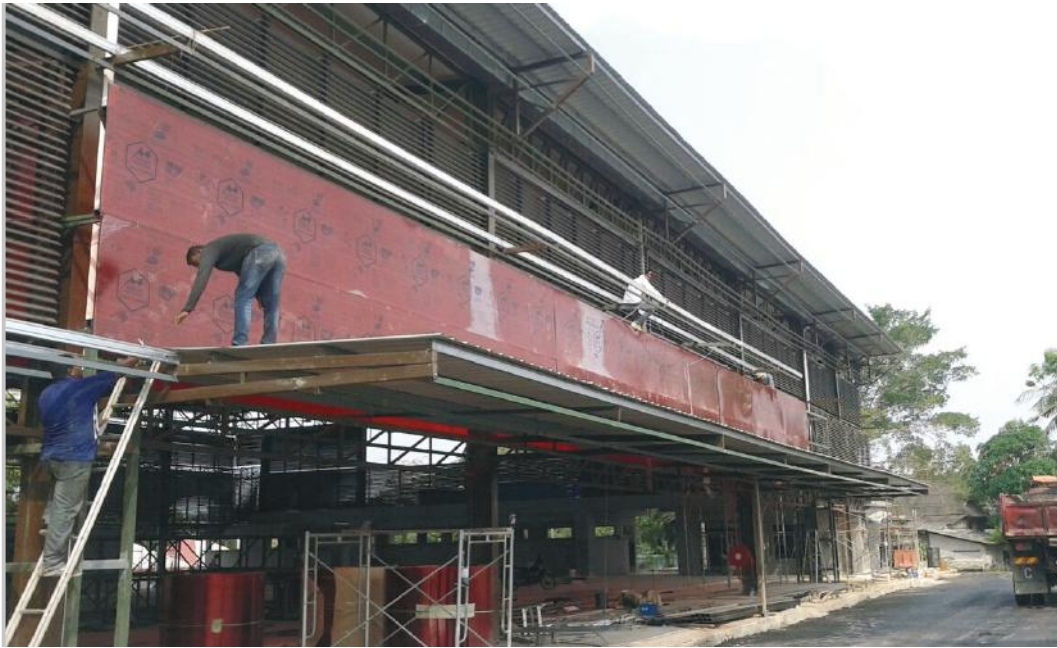
Kerja-kerja pembinaan PAKAR Kuala Kedah, Kedah Construction Works of PAKAR Kuala Kedah, Kedah
