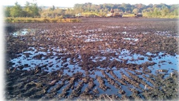
2,6 ha de tourbe superficielle dégradée ont été enlevés et utilisés pour combler des drains et restaurer des zones de hauts fonds dans les étangs favorables à la création de tourbe ©CEN HdF
