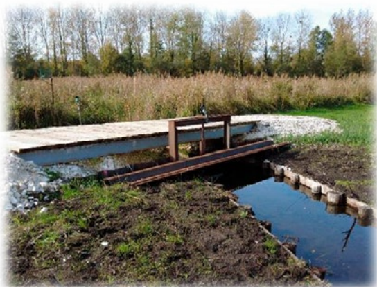
4 seuils hydrauliques ont d'ores et déjà été implantés pour soutenir les niveaux d'eau de la tourbière ©CEN HdF
