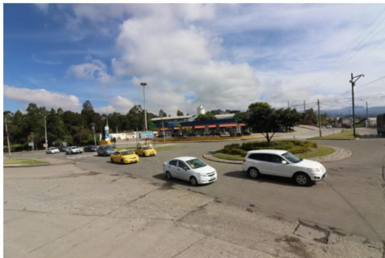
En la Avenida de las Américas se construirá un paso a desnivel para mejorar el tránsito. PSR
