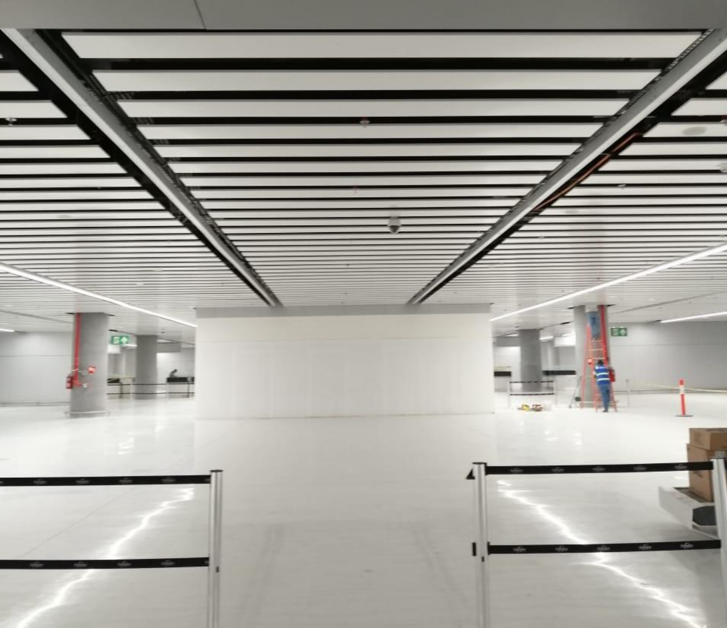
AEROPUERTO TOCUMEN FOSTER & PARTNERS PANAMA CIELO PLANK Y CIELO BAFFLE
