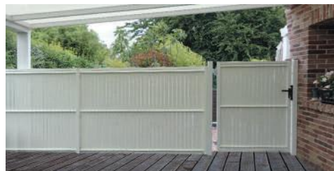
Pose en claustra de séparation
