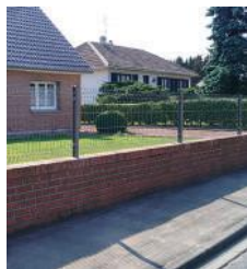
Pose sur muret
